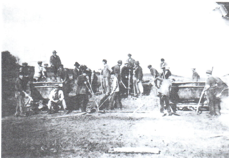
Um 1930 Bau des Sportplatzes im Rahmen von Notstandsarbeiten. Hilfsmittel: Hacke, Schippe, Spaten und Lore.
